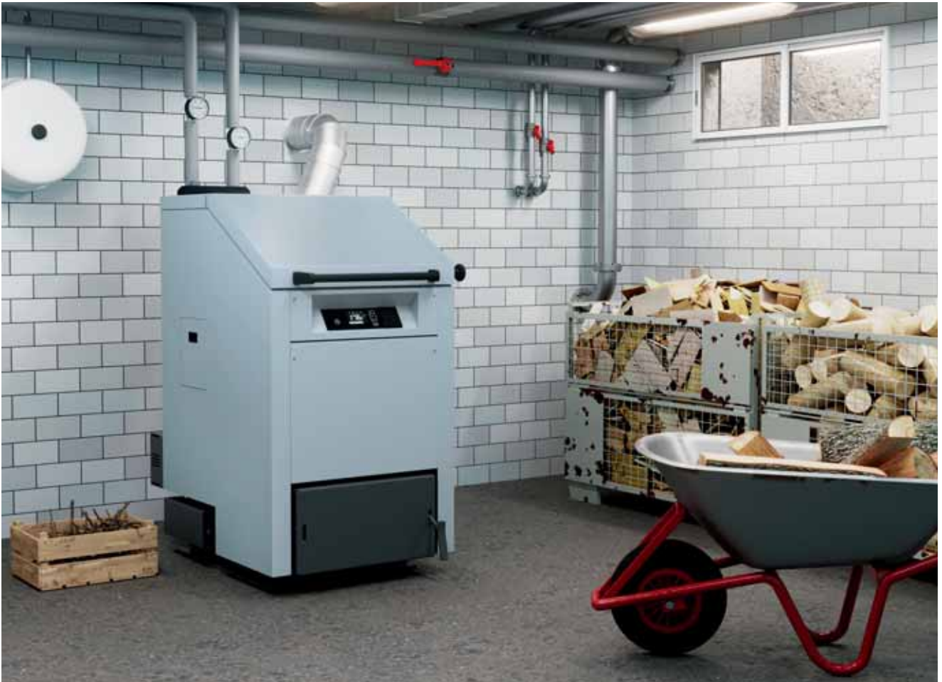
Scheitholz-Vergaserkessel Vitoligno 300-S – manuell von oben beschickbar
